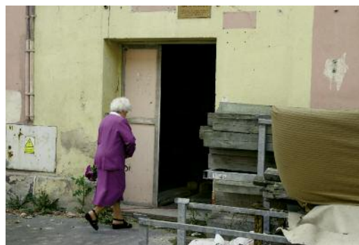
Rok temu Urząd Gminy sprzedał kamienicę prywatnemu inwestorowi. Od tamtego czasu opuszczony budynek, w którym pozostała tylko kaplica, niszczeje
