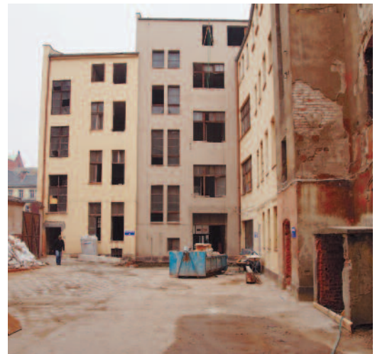
Widok na budynki i oficynę od strony podwórka
